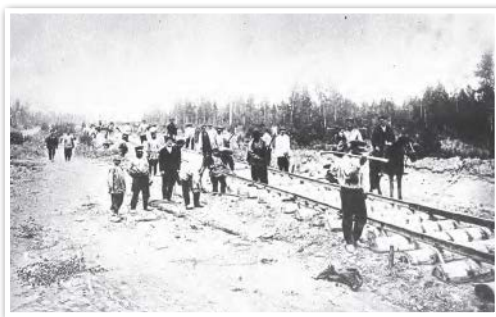
Рабочие укладывают рельсы на строительстве железной дороги в Беларуси.
